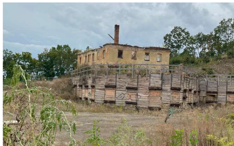
obr. 01. Usedlost Skalka - současný stav
