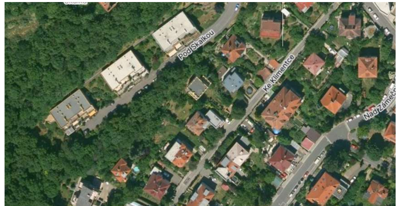
obr. 08. Vilové domy pod Skalkou - ulice Nad Zámečnicí a Ke Klimentce, zdroj: Mapy.cz
