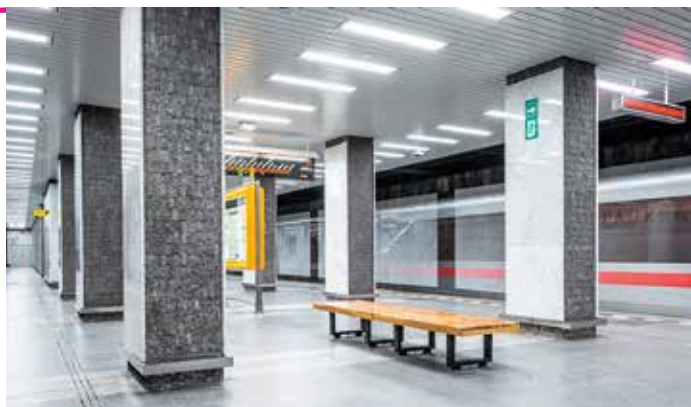
Modernizace stanice Pankrác.
