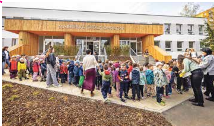
Zrekonstruovaný pavilon mateřské školy v Ohradní ulici.
