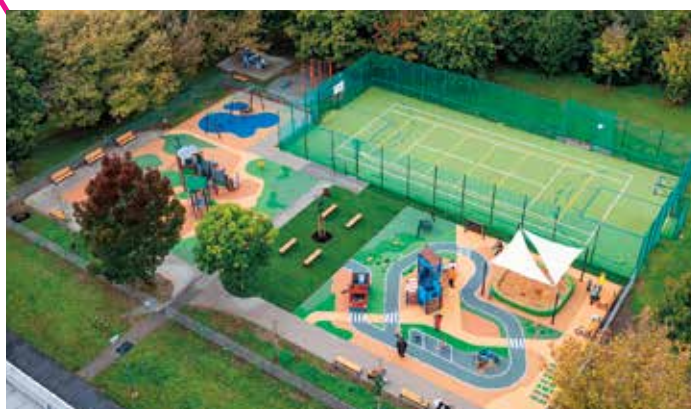
Zrekonstruované hřiště v Trnavské ulici.
