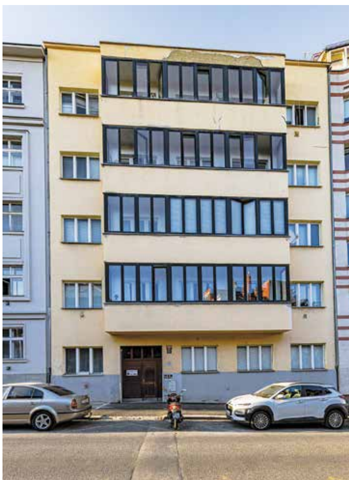
Atypický dům s pásovými okny v ulici Pod Vilami. Foto: Martin Frouz
