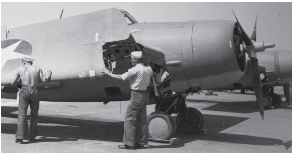
Zásadní inovací bylo u verze F4F-4 skládací křídlo systému „So-Wing“, který navrhl přímo Leroy Grumman. Zde demonstrují prostorovou úspornost systému mechanici na letounu náležejícímu VF-3 na základně NAS Kaneohe, Oahu, 29. května 1942.
